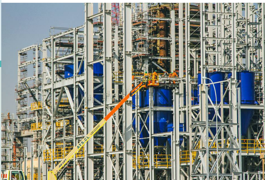
Figura 18_ Planta Molyb en Mejillones, durante su construcción en el año 2015
